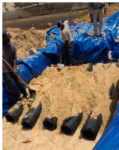
Installation des rangées de conduites
